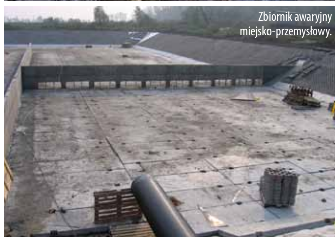
Remont zapory przeciwrumowiskowej.
